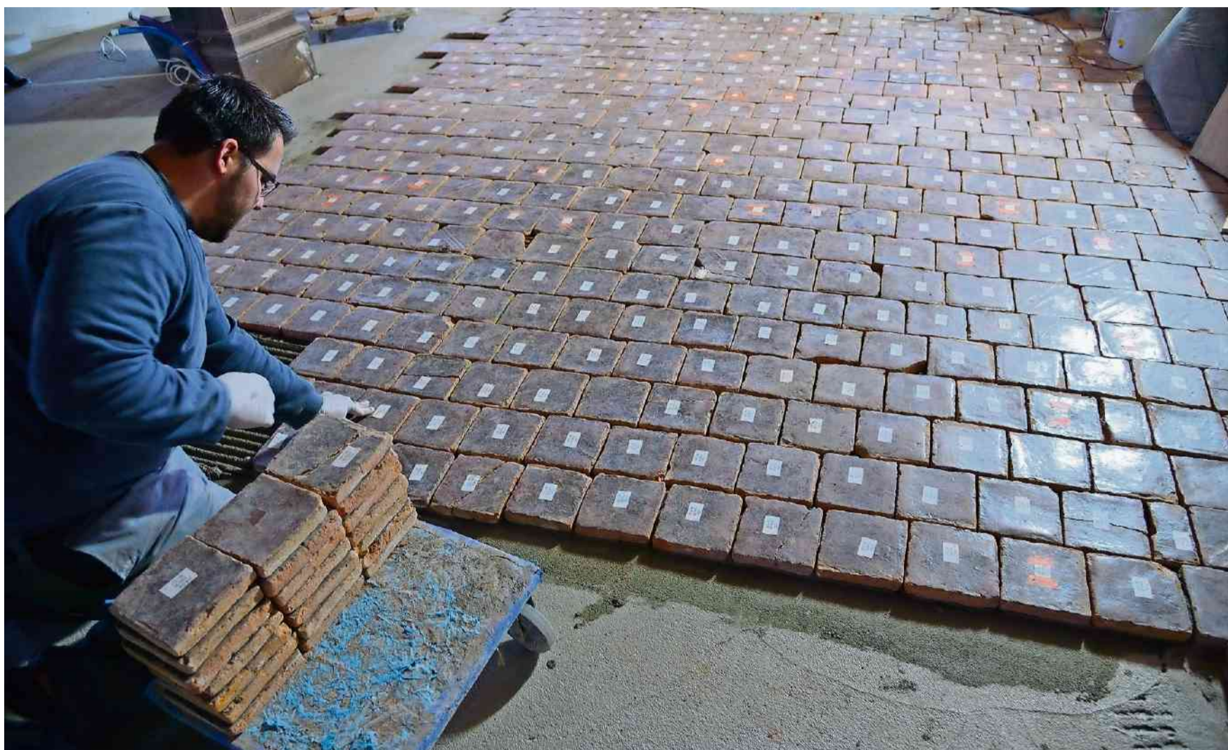
Plattenleger-Vorarbeiter Agron Abdullah fügt mit viel Fingerspitzengefühl Tonplatte um Tonplatte zusammen. Er folgt dabei streng den durchnummerierten Platten.
