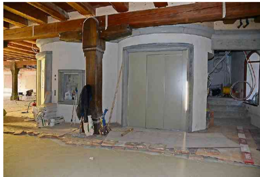
Der neue Lift und das Treppenhaus sind in historischem Stil gebaut.
