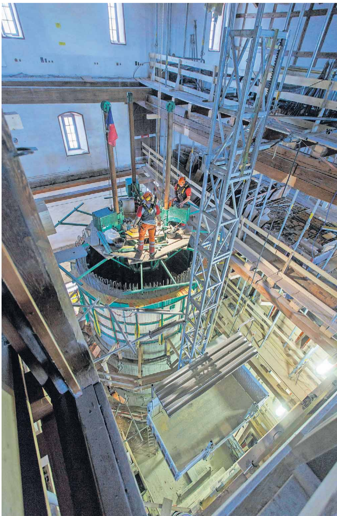
Der Betonturm wächst in die Höhe. Ein neues Treppenhaus und der Lift werden darin eingebaut.
