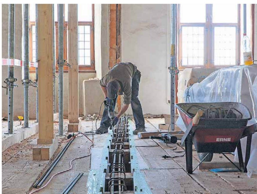
In die alten Dachbalken werden Eisen verlegt und diese ausbetoniert.
