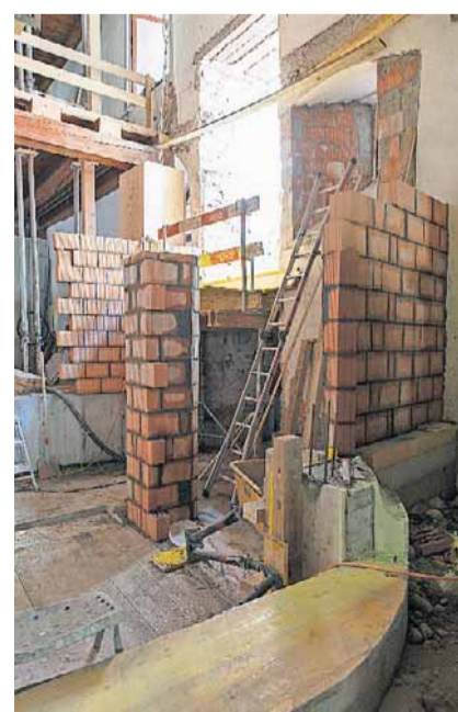
Hier entsteht ein neuer Eingang.
