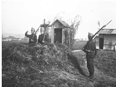
Soldaten während der Grenzbesetzung vor einem Wachhäuschen, das durch einen Erdwall geschützt und durch Zweige getarnt ist: hinten die Soldatenunterkunft mit einem zuschauenden Knaben, 1914 (Bestand Mangold, Basel).
